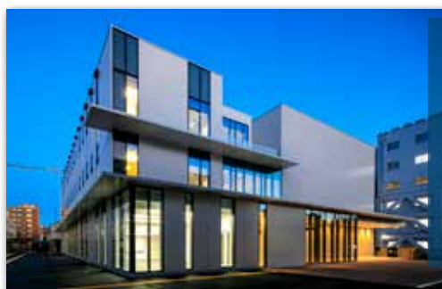
完成したばかりの新音楽棟
